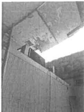
Rua S. Pedro, 67, 69 e 73- Interior
