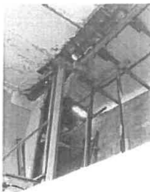
Rua S. Pedro, 67, 69 e 73- Interior
