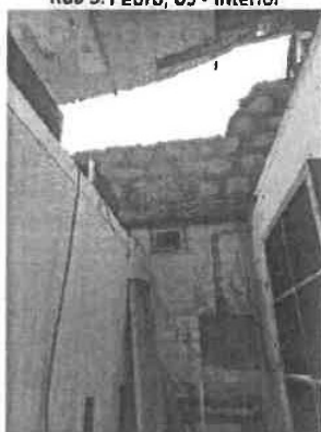
Rua S. Pedro, 67, 69 e 73- Interior
