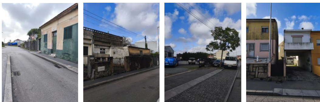
Figura 3. Levantamento fotográfico dos alinhamentos e recuos existentes no troço sul da Rua de Picoutos, entre a Rua do Tronco e a Rua 5 de Outubro.
