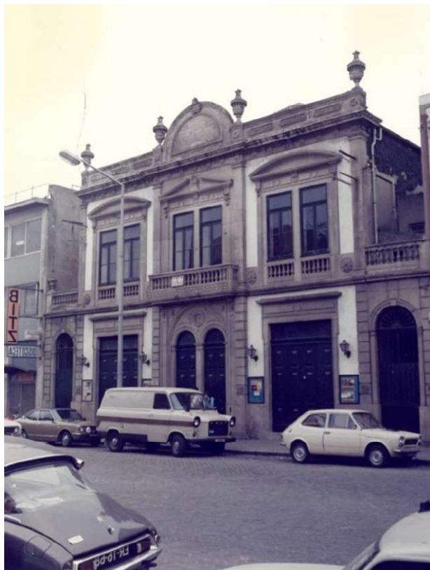
Fotografia de 1985, do Levantamento do Património do Concelho, com o Teatro ainda em funcionamento.
