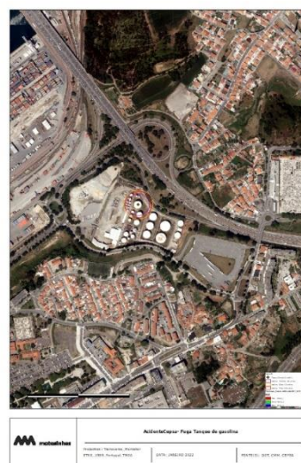
Figura 71. Acidente CEPESA - Fuga em tanque de gasolina
