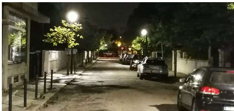
Figura 43 – Interferência da Arborização na Iluminação Pública
