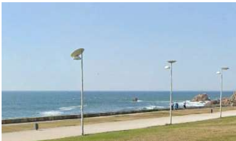
Figura 19 - Luminárias Sujeitas a uma Atmosfera Corrosiva 9
