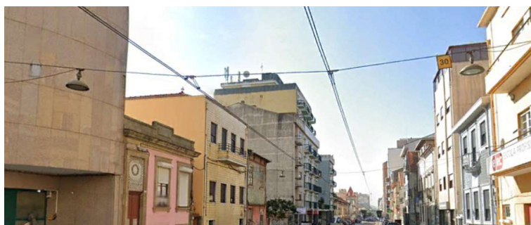
Figura 49 - Luminárias em Suspensão - Rua de Brito Capelo 17
